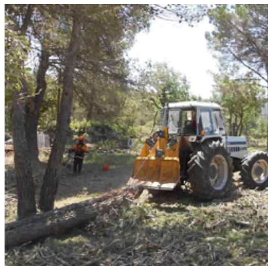
Franja de seguridad perimetral en ejecución. Fuente: DIBA
