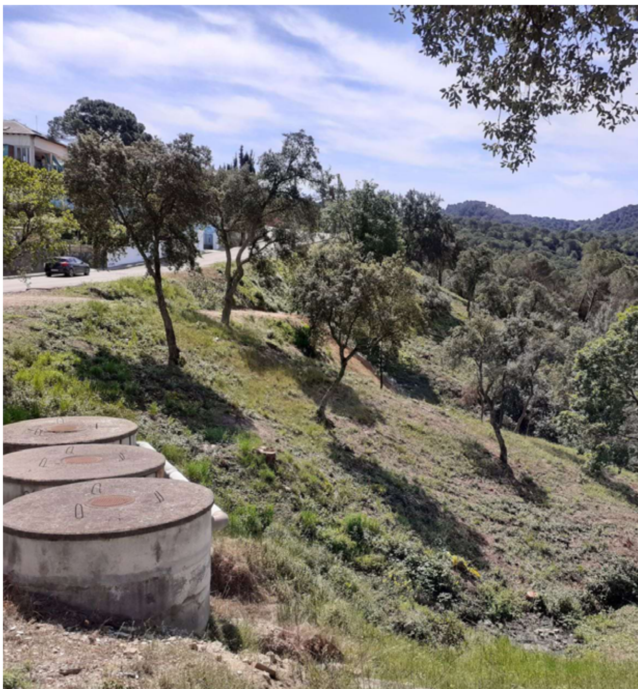
El PPU de la Diputacion de Barcelona minimiza la afectacion de los incendios forestales en zonas residenciales. Fuente: DIBA
