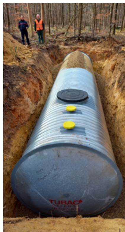
Instalación de un depósito de agua enterrado de 30 m 3 . Fuente: Unidad territorial ONF Fontainebleau
